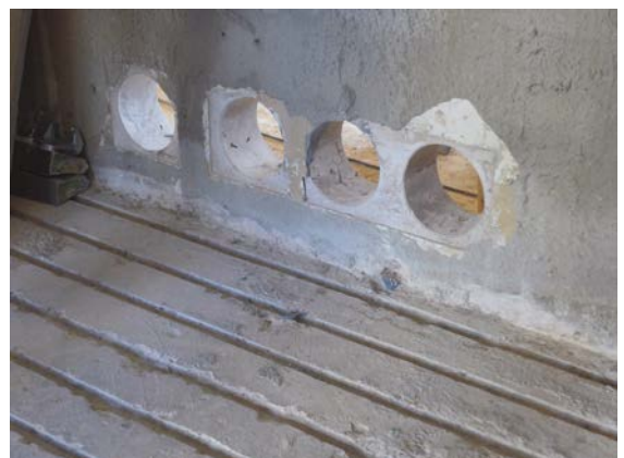
Abb. 133 Aufwendige Nacharbeiten am Rohbau: Kernbohrungen zur Leitungsführung und Ergänzung der oberen Bewehrungslage im Deckenbereich [© Andreas Dalkowski/BF Vario]
