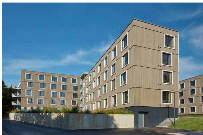
Abb. 34 Bochum: Trotz einheitlicher Fensterformate eine Fassade ohne Monotonie [© Sigurd Steinprinz/ACMS Architekten GmbH]
