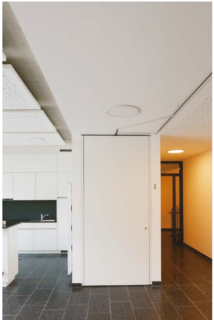
Abb. 154 Raumtrennende Schiebetür, die den Mehrzweckraum mit Küchenbereich bei Bedarf von der Erschließung separieren kann [© Ingo Wiederoder/BF Vario]
