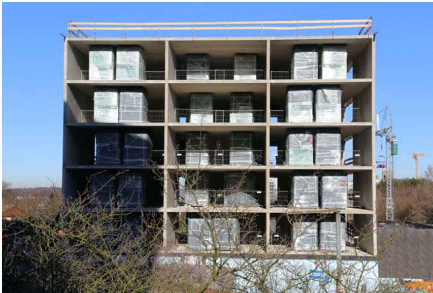
Abb. 31 Wuppertal-Griffenberg: Die Nasszellen stehen, raumweise zugeordnet, bereit zum Einbau. [© ACMS Architekten GmbH]
