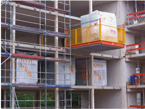
Abb. 20 Bochum: Die Stahlleichtbau-Nasszellen werden vor Montage der Fassade in den Rohbau eingeschoben. [© Günter Löhnert/BF Vario]
