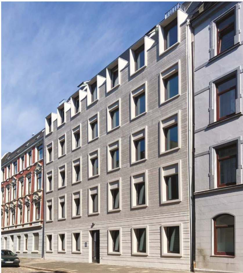
Abb. 97 Ersatzneubau in gründerzeitlicher Blockrandbebauung [© Heiko Sandelmann]
