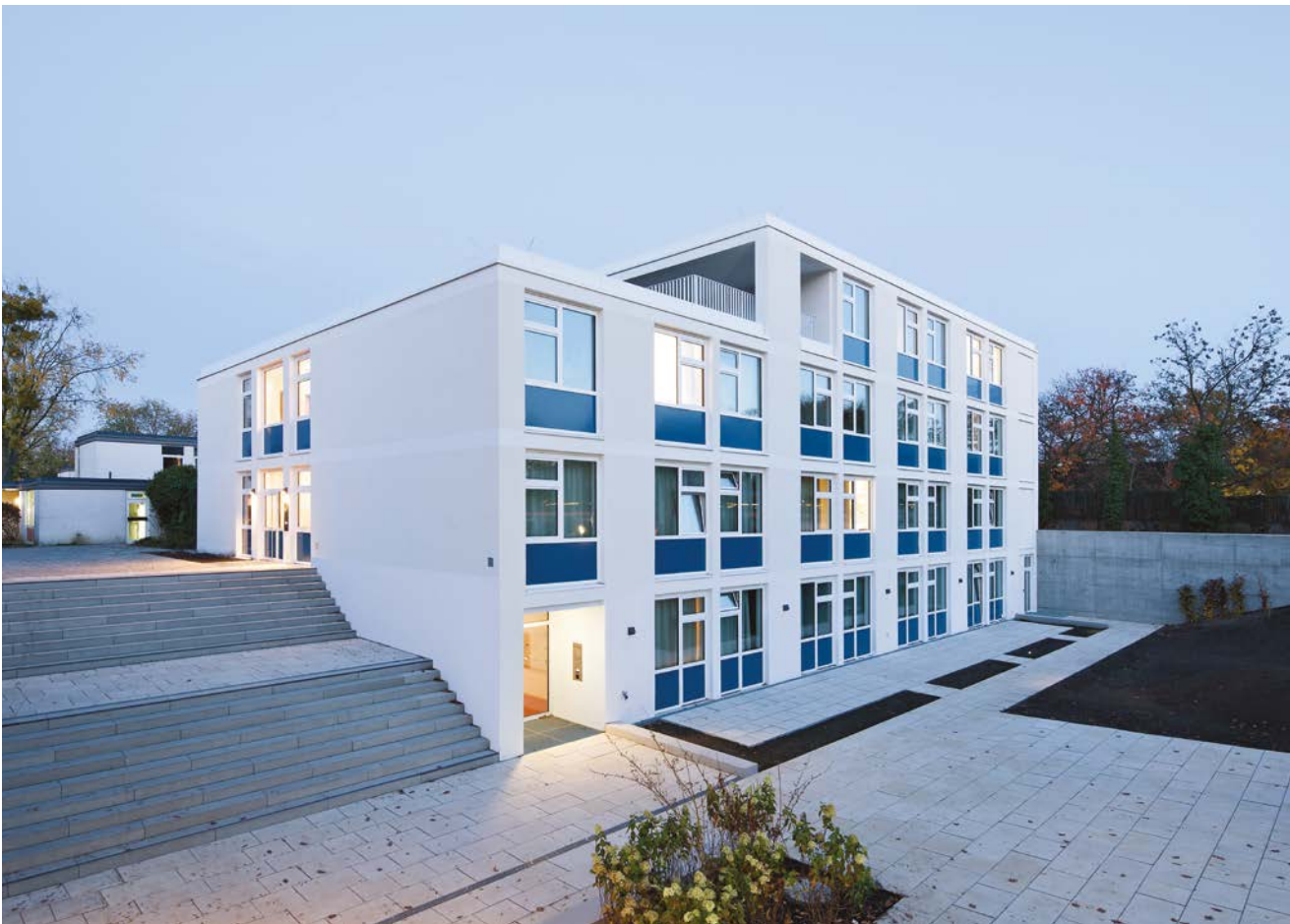
Abb. 80 Ansicht mit Freitreppe [© Andrew Alberts/studierendenWERK BERLIN]
