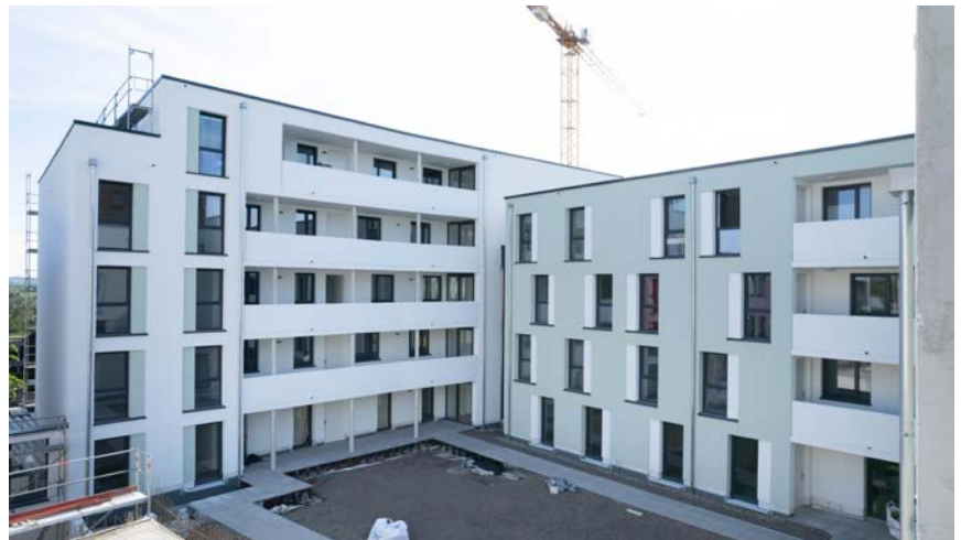
Abb. 162 Die Gebäude orientieren sich mit Laubengängen zum Innenhof. [© BBSR/ BILDKRAFTWERK/Peter-Paul Weiler]
