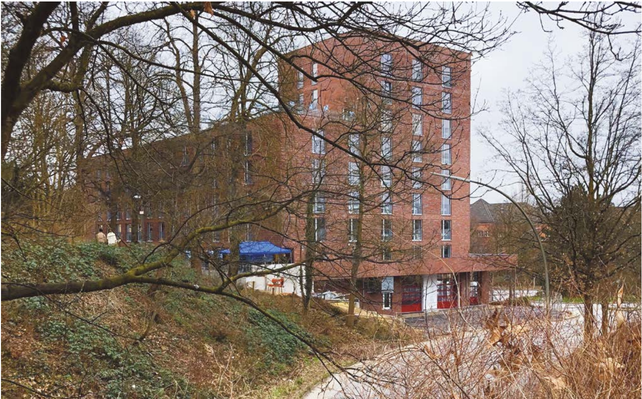
Abb. 134 Über dem Sockel mit der separaten Nutzung durch die Feuerwehr ist das Azubi-Wohnheim in einem 5-geschossigen und 8-geschossigen Gebäudeteil untergebracht. Links ist die Dachterrasse erkennbar [© Bettina Stinner/BMI]
