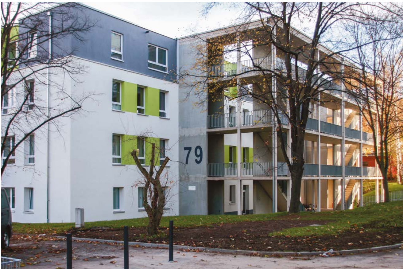
Abb. 108 Das ehemalige Blutspendezentrum mit vorgelagerter neuer Erschließung [© Friedrich May/BF Vario]
