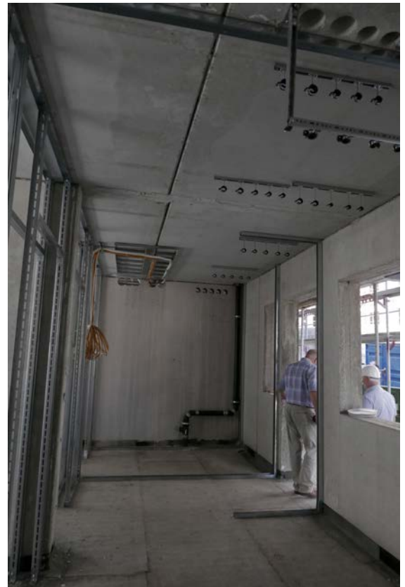
Abb. 159 Die Bauweise mit überwiegend Fertigteilen für Wände und Decken sorgte für eine rasche Erstellung des Rohbaus. [© Ingo Wiederoder/BF Vario]
