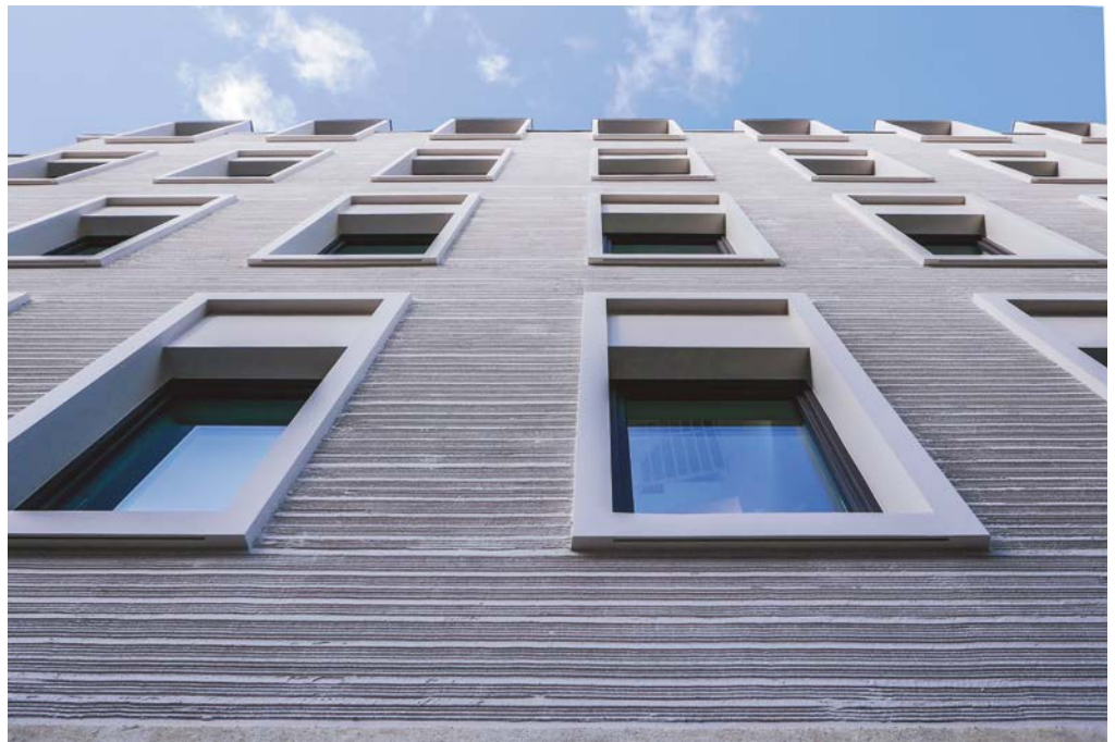
Abb. 98 Ersatzneubau in gründerzeitlicher Blockrandbebauung [© Friedrich May/BF Vario]
