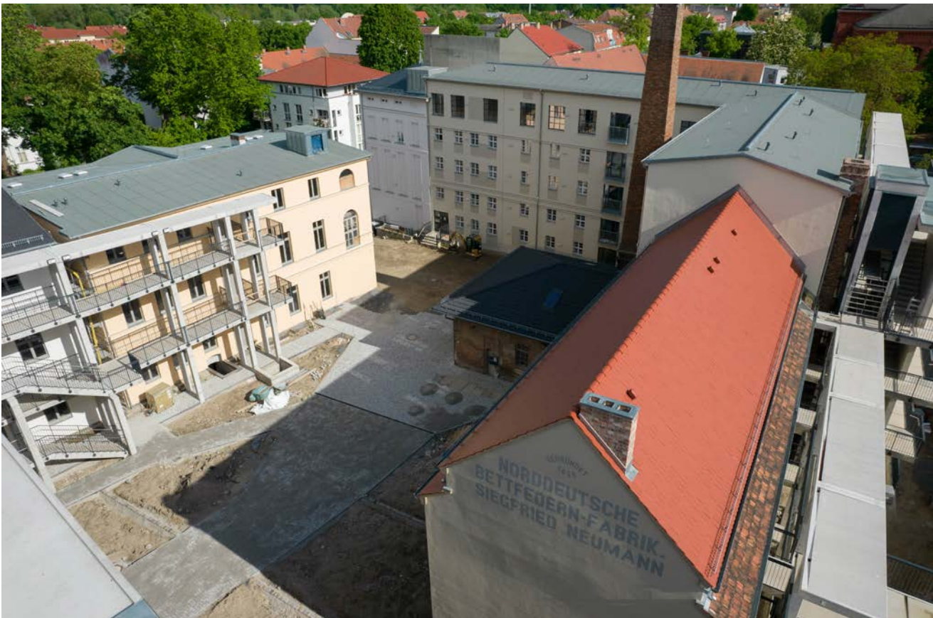
Abb. 120 Ensemble der Ferdinandshöfe, bestehend aus insgesamt 7 Häusern. Mittig das ehemalige Kesselhaus. [© BBSR/BILDKRAFTWERK/ Peter-Paul Weiler]
