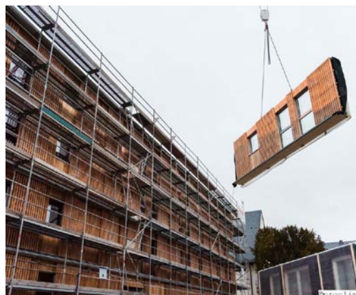
Abb. 149 Vorgefertigte Außenwandelemente werden komplett mit Bekleidung und Fenstern montiert. [© Züblin Timber]
