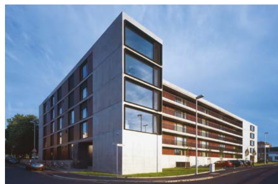
Abb. 198 Fassade zur stark befahrenen Straße [© Wolfgang Dürr, Fotografie/Michel+Wolf+Partner Freie Architekten BDA]
