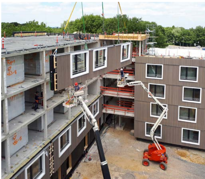
Abb. 17 Bochum: Montage der geschosshohen Fassadenelemente [© ACMS Architekten]
