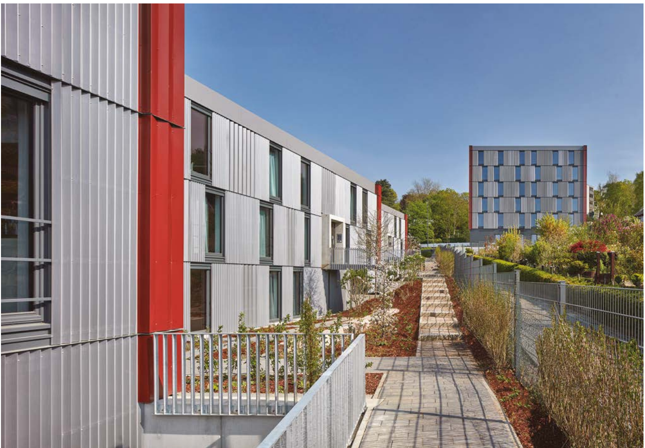
Abb. 179 Gartenseite des Ensembles mit Erschließung, Bewohnergarten und Blick auf den Solitär [© Sigurd Steinprinz/ACMS Architekten GmbH]
