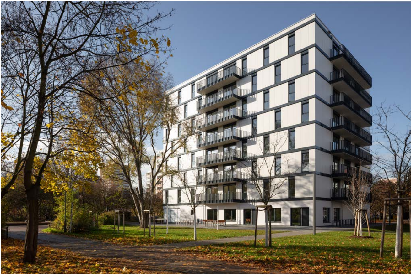
Abb. 86 Das Vario-Gebäude vom Park gesehen [© thoma architekten/Thomas Bruns]
