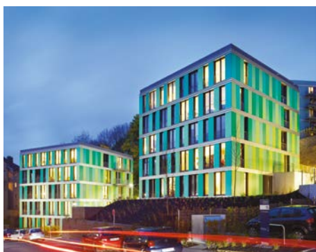
Abb. 201 Bunte Fassaden für die Würfel [© Sigurd Steinprinz/ACMS Architekten GmbH]
