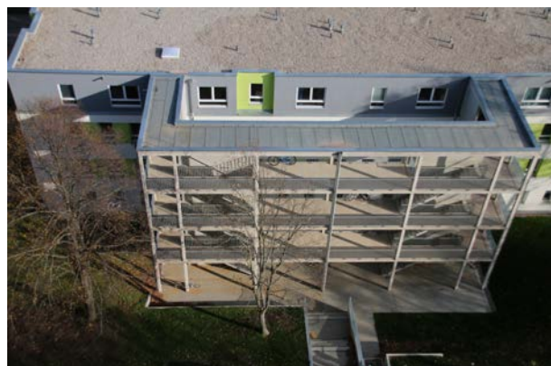
Abb. 44 Erfurt: Bei der Sanierung hinzugefügtes Erschließungselement als Begegnungsraum [© Friedrich May/BF Vario]
