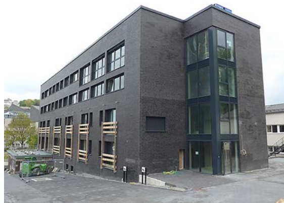
Abb. 67 Meschede: Ehemaliges Arbeitsamt nach der Sanierung [© Günter Löhnert/BF Vario]
