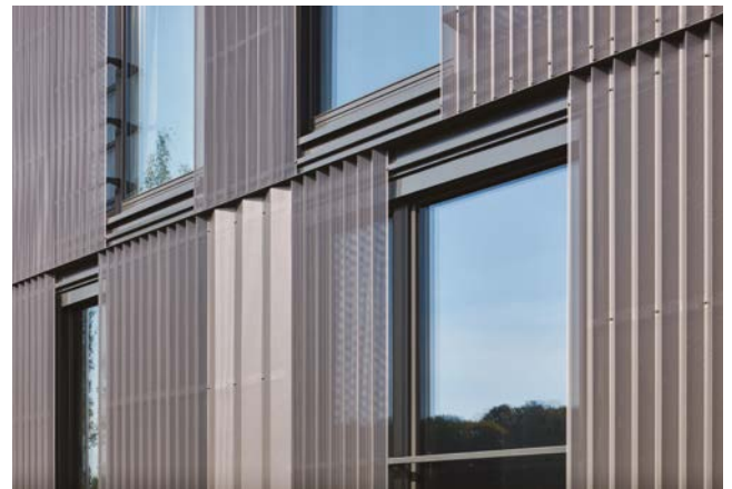
Abb. 181 Das Fassadenblech ist verschieden gefaltet und teilweise perforiert und soll ein Bild von zugezogenen und leicht geöffneten Vorhängen erzeugen [© Sigurd Steinprinz/ACMS Architekten GmbH]
