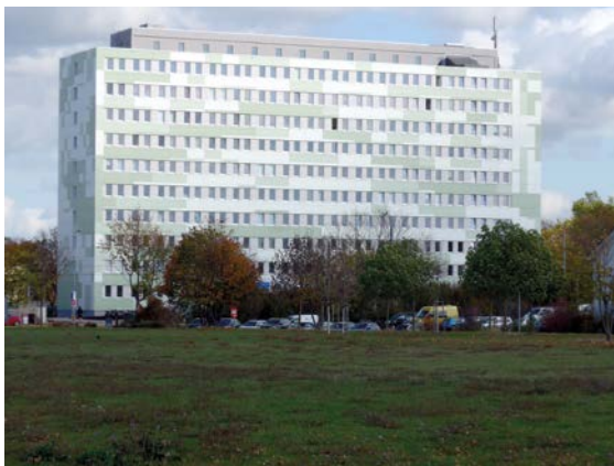
Abb. 66 Erfurt: Ehemalige Zahnklinik nach der Sanierung [© Günter Löhnert/BF Vario]
