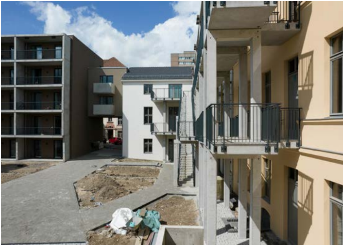
Abb. 124 Hofansicht nach Osten mit Blick auf die Neubaugängung (Haus 8). Rechts ist die vorgestellte Erschließung aus Betonfertigteilen zu erkennen. [© BBSR/BILDKRAFTWERK/Peter-Paul Weiler]
