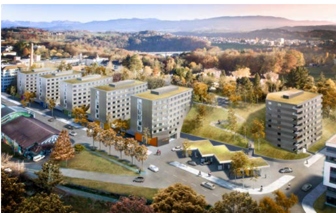
Abb. 208 Blick auf die Anlage am Steilhang [© apartis Stiftung für studentisches Wohnen]
