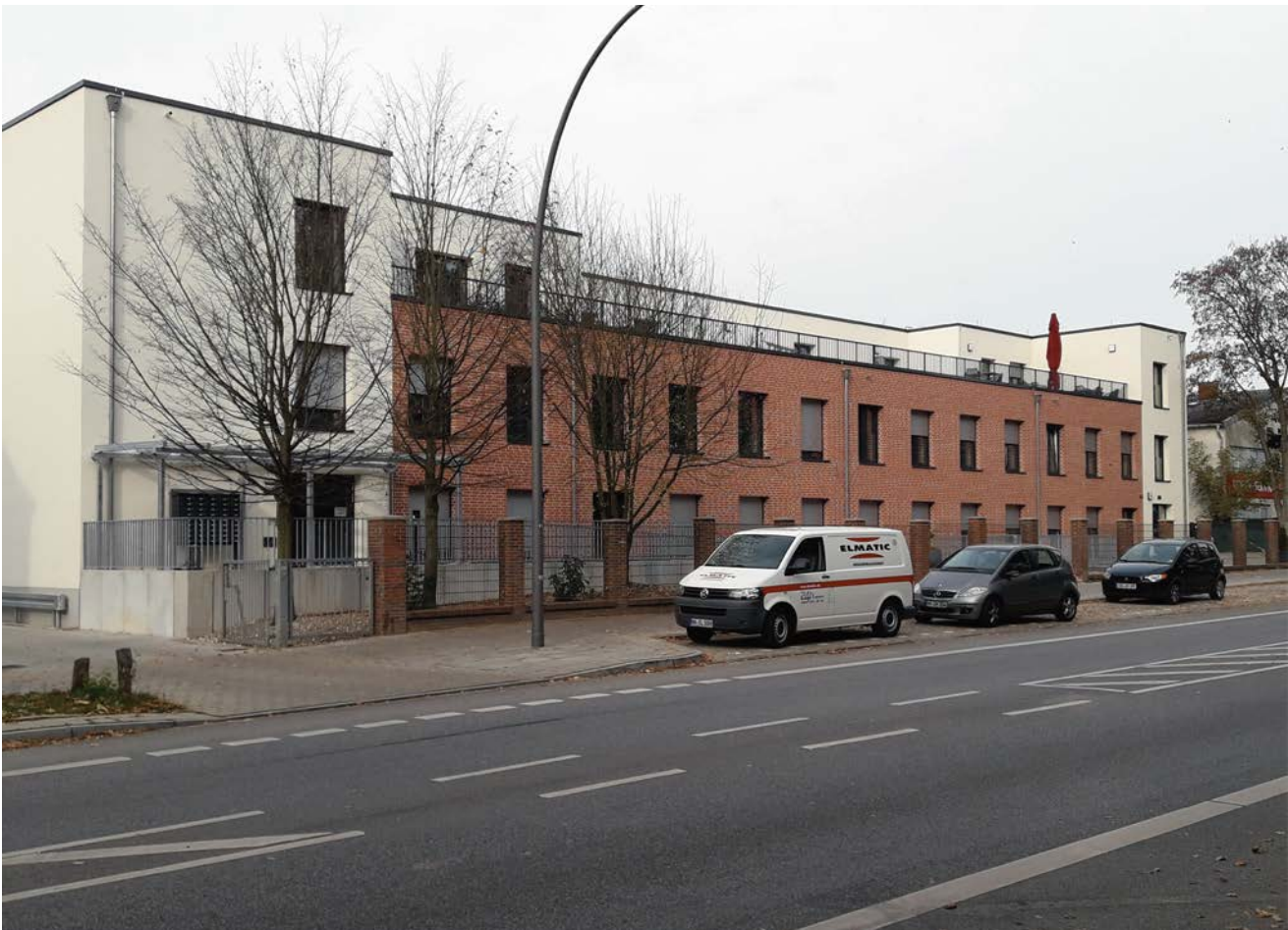
Abb. 139 Auszubildendenwohnheim mit großer Dachterrasse [© Octillion Capital]
