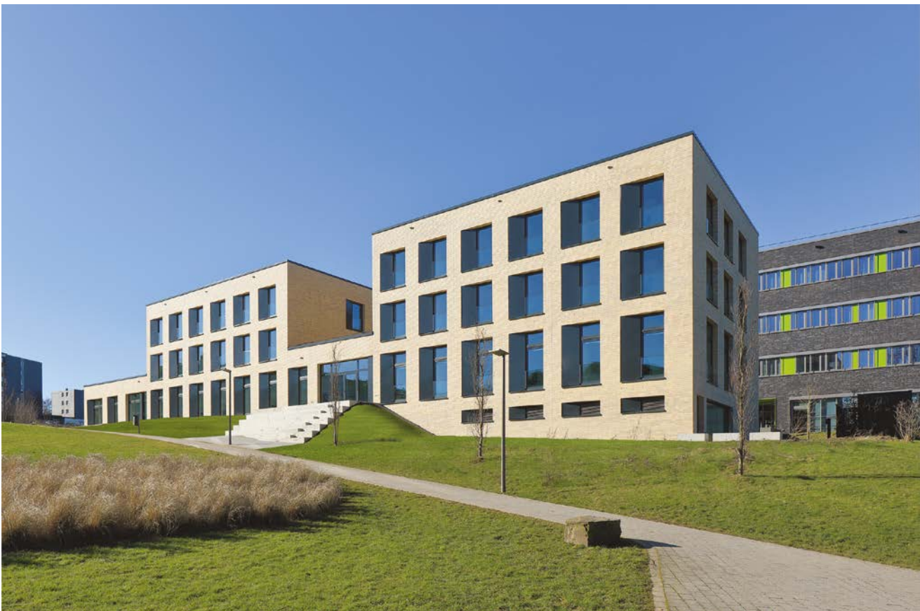
Abb. 150 Ostansicht des Neubaus mit Freitreppe zum Park, im Hintergrund Bestandsgebäude auf dem Campus [© Hans Jürgen Landes, Dortmund]
