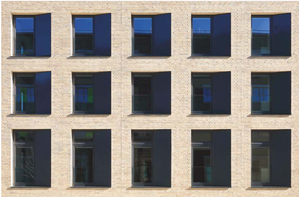
Abb. 151 Fassadenausschnitt: Gut zu erkennen sind die gestalterisch eingesetzte Absturzsicherung aus Glas sowie eine Blechverkleidung neben dem Fenster, hinter der sich die dezentrale Luftansaugung für jeden Raum befindet. [© Hans Jürgen Landes, Dortmund]
