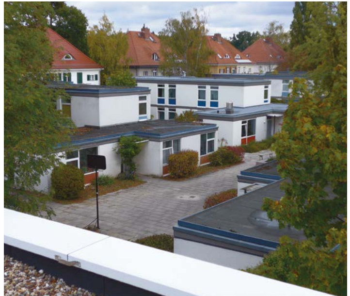
Abb. 81 Blick auf die Bestandswohnanlage unter Denkmalschutz [© Günther Löhnert/BF Vario]
