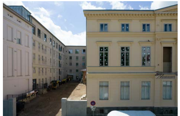
Abb. 122 Straßenseitiger Eingang auf den ehemaligen Brauereihof vorbei an der ehemaligen Darre (links) und dem Wohngebäude Haus 2. [© BBSR/BILDKRAFTWERK/Peter-Paul Weiler]
