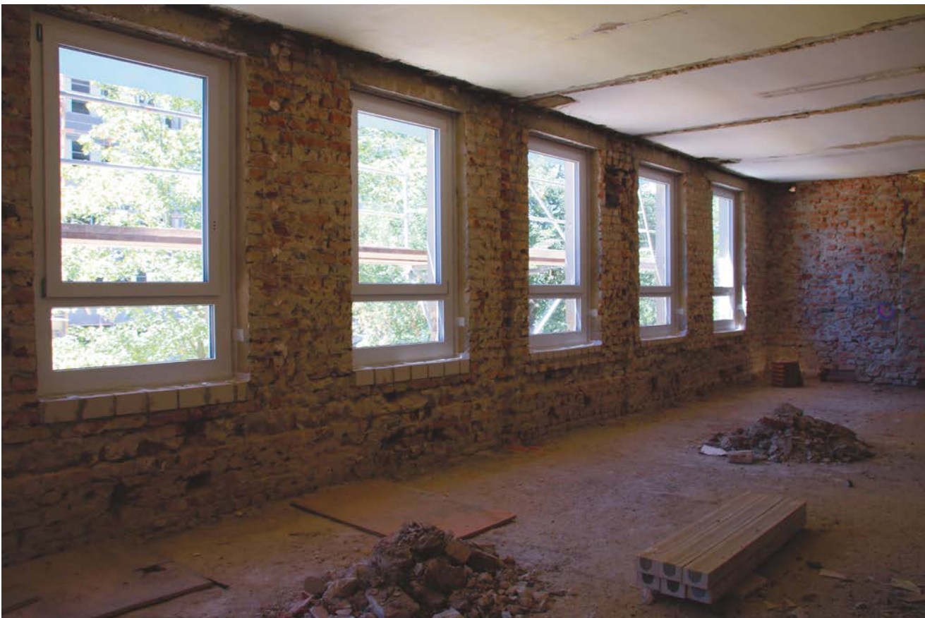
Abb. 112 Bestandsaußenwand in Vollziegel [© BF Vario/Günter Löhnert]
